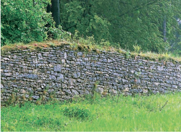
Abb. 5: In den 1980er Jahren wurde ein Mauerabschnitt auf dem Nesselberg vor- bildlich mit Kalkmörtel und einer Abdeckung aus Rasensoden saniert Foto: Lara Diekmann (Hannover)
