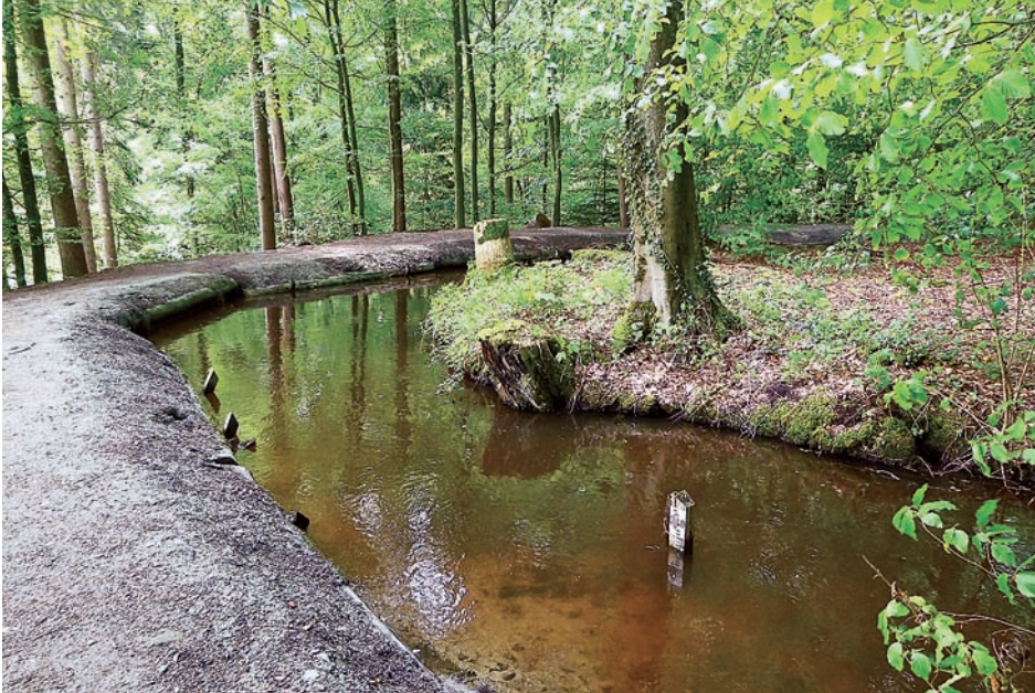
Abb. 4: Kanalabschnitt des Stillen Bachs im heutigen Landschaftsbild. Der hangparallele Verlauf ermöglichte die Regulierung der Fließgeschwindigkeit Ch. Vossler-Wolf
