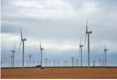
Abb. 9: Neue Windkraftanlagen in den Reußenkögen bei stürmischen Westwind 08.08.2016
