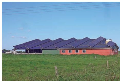
Abb. 3: Hof bei Dörpstedt westl. Kropp mit Solarpanelen 13.05.2009
