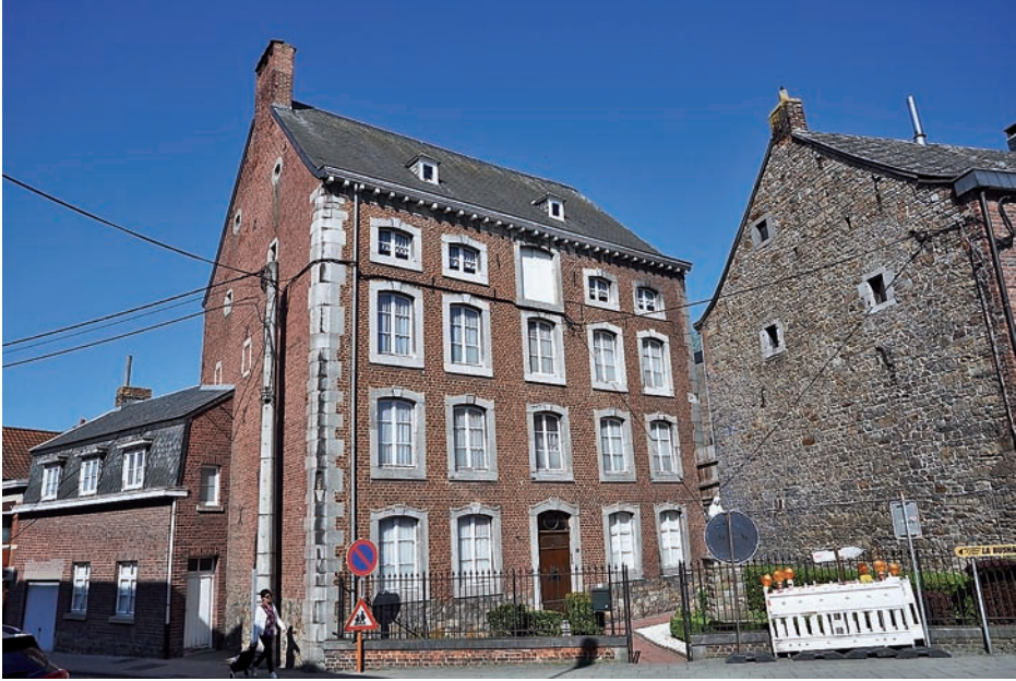
Abb. 10: Ehemalige Kaufmannswohnung mit Fassade aus dem 18. Jahrhundert nahe dem Aubeler Markt. Die weiße Luke ermöglichte den Zugang zum Getreidespeicher Quelle: Lambiet 1988, S. 153–156, Foto: M. Paulissen
