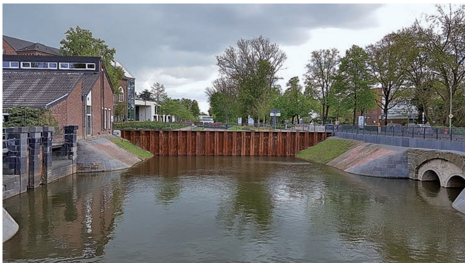
Abb. 13: Restauriertes Épanchoir des historischen »Nordkanals« (im Hintergrund Visualisierung, Abb. 12) Neuss, Nordrhein-Westfalen
