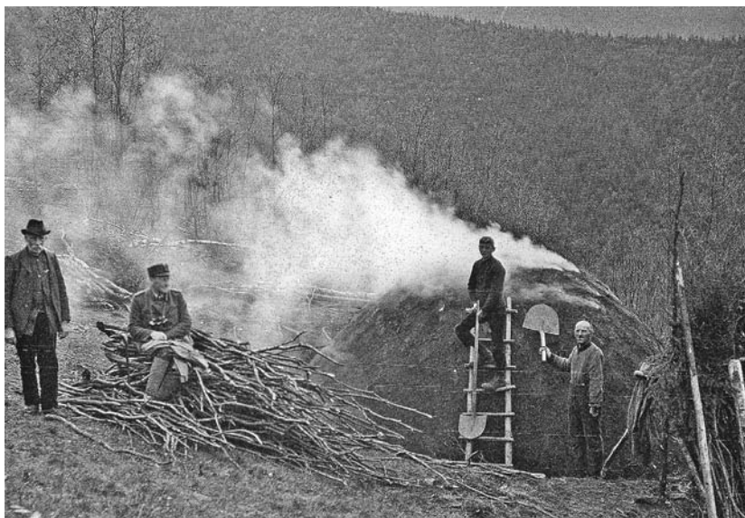
Abb. 1: Kohlenmeiler bei Walpersdorf im Siegerland. Im Siegerland war die Köhlerei eng mit der Haubergswirtschaft verknüpft Foto aus einem Dia-Vortrag des Kreishauberg-Oberförstlers Paul Sorg aus dem Jahr 1932 (Forstliche Dokumentationsstelle, Wald und Holz NRW)
