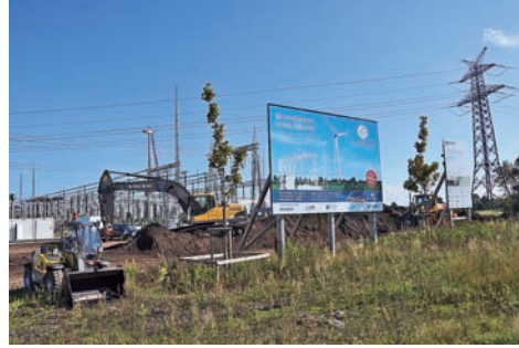
Abb. 14: Bau des Umspannwerks Jarde-lund, u.a. für den Bürgerwindpark Medelby 04.09.2014
