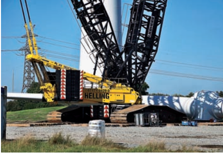
Abb. 13: Montage-Details von Abb. 12, Kran und liegende Flügel
