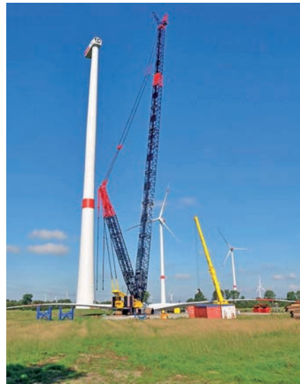
Abb. 12: Montage des 100 m hohen Mastes einer 3,2 MW-Anlage für den Bürgerpark Medelby 04.09.2014
