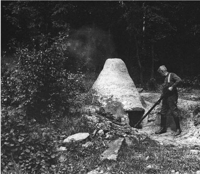
Abb. 2: Nachbildung eines La Tène-zeitlichen Schmelzofens im Giebelwald, westlich von Siegen, Foto um 1955 Aus: Becker, Alfred (1991): Der Siegerländer Hauberg. – Kreuztal, S. 13
