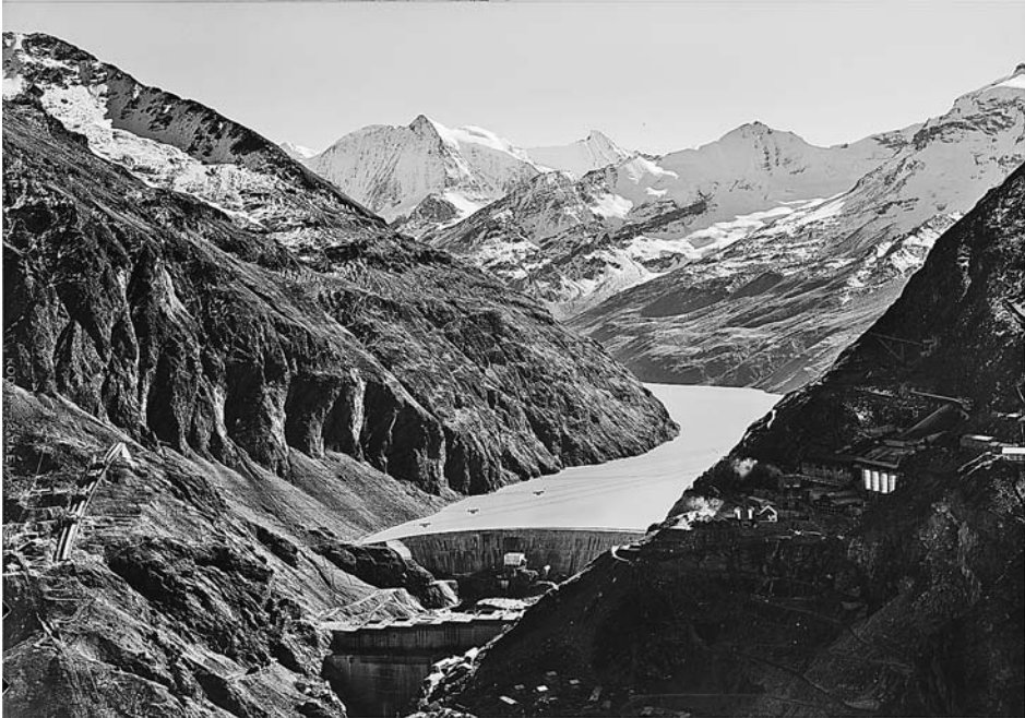
Abb. 2: Alte Staumauer der Grand Dixence von 1931 und Bau der 285 Meter hohen, neuen Staumauer im Jahr 1955
